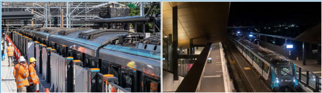
〈Southwest 구간 메트로 시범 운행〉
